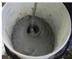
Versare **5 kg** di DYNACEM nel recipiente di miscelazione e aggiungere da **1,25 a 1,40 litri di acqua** (Per temperature sotto lo zero, miscelare la versione standard con acqua tiepida max. 15°C). Mescolare intensamente la massa per circa 2 minuti fino a ottenere un composto omogeneo. Più energicamente si mescola la miscela, più liquida sarà la massa.
