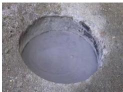
Bohrlöcher nie ganz auffüllen. Ca. 2 cm leer lassen. Um den abbindenden Zement vor Sonneneinstrahlung (Wärme) oder vor Frost und Regen zu schützen, empfiehlt es sich, die gefüllten Löcher mit Fließ oder anderem geeignetem Material abzudecken.
