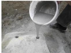
Masse sofort nach dem Mischen direkt aus dem Mischbehälter in die Bohrlöcher einfüllen. Wenn direktes Einfüllen nicht möglich ist, kann auch ein Trichter verwendet werden. **Verarbeitungszeit: 5 Minuten. WICHTIG: SCHUTZBRILLE TRAGEN !**
