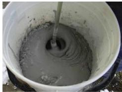
DYNACEM **5 kg** in den Mischbehälter schütten und **1.25 bis 1.40 Liter Wasser** zugeben. (Bei Minusgraden Standard-Version mit warmem Wasser anmischen **max. 15°C**). Masse ca. 2 Minuten intensiv rühren, bis eine homogene Mischung erreicht ist. Je kräftiger gemischt wird, desto flüssiger wird die Masse.
