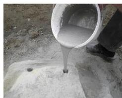
Immediatamente dopo la miscelazione, versare il composto direttamente dal contenitore di miscelazione nei fori. Se non è possibile il riempimento diretto, è possibile utilizzare anche un imbuto.
