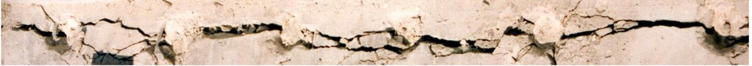
**Les trous vides "repoussent" les fissures.** Une rangée de trous vides définit la limite de la zone de cassage de l'élément.
